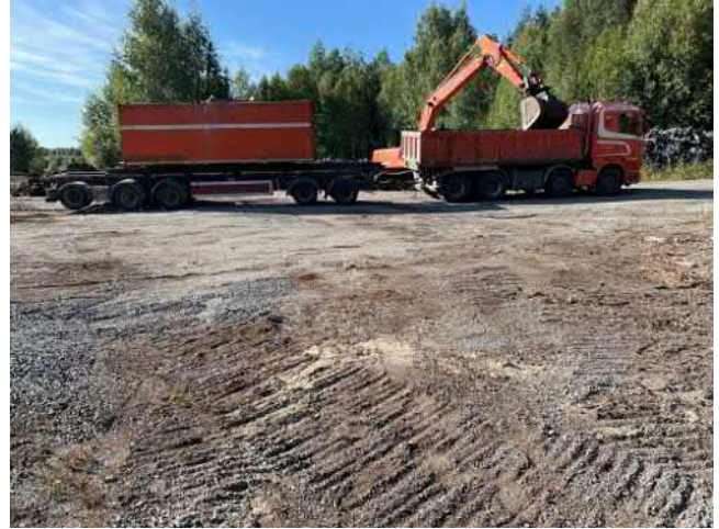
Kaivetaan vielä kentältä maata kohdalta missä todettiin kynnysarvon ylitys
