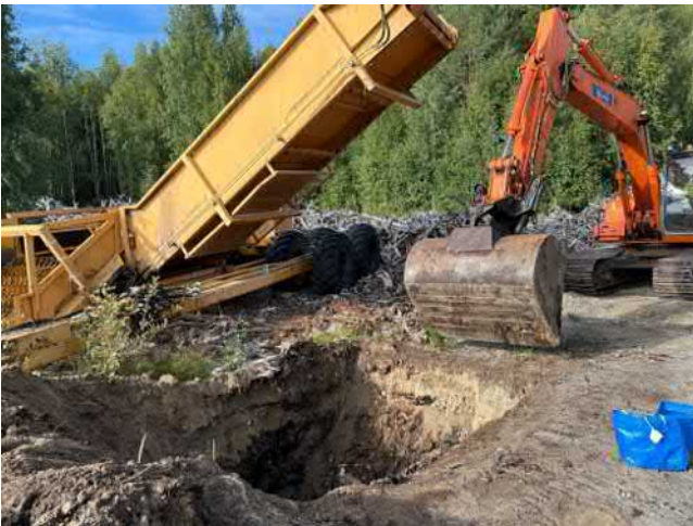
KK6 kohdalta kaivettu 1,5m syvyyteen, eli varmistettu turvetta noin 0,5m
