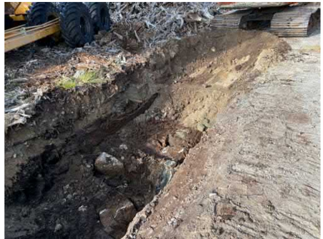
Kaivuu menossa KK5 kohta osittain kesken,
