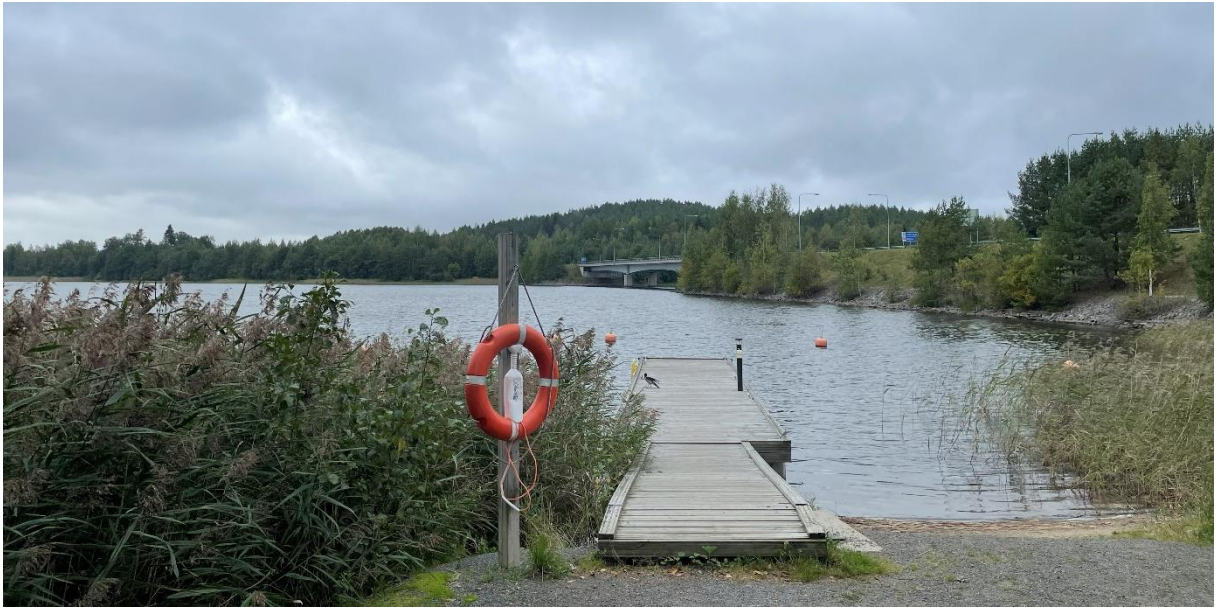
Kuva 14. Kuva Hartolan puolelta kohti valtatieä 4 ja Oravakivensalmen siltaa.
