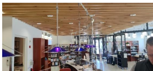
Kirjaston valaisimien kunto kohtuullisen hyvä. Valaisimien sijoittelu ja suuntaus ei palvele käyttötarkoitusta.
