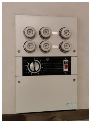
Saunan ohjauskeskus alkuperäinen. Tulisi uusia.
