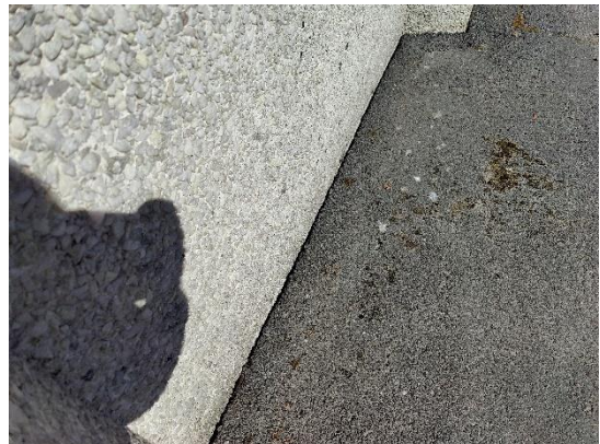
Sokkeliä vasten on käytetty myöskin asfalttia. Asfaltin rajaukseen syntynyt muutaman sentin rako.
