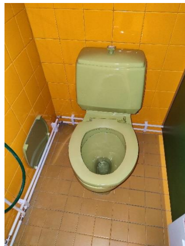
Alkuperäinen WC-istuin. WC-istuimen kansi on hajalla.
