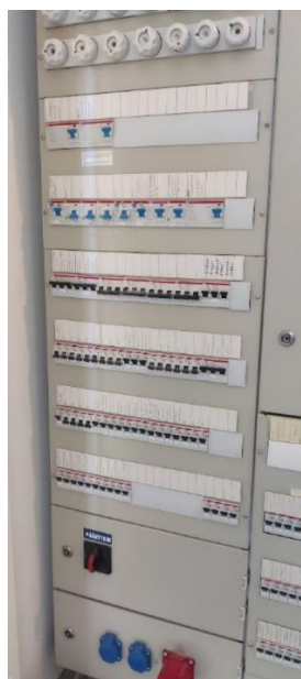
Kirjaston ryhmäkeskus uusittu 2004, osittain viikavirtasuojattuja pistorasiaryhmiä.
