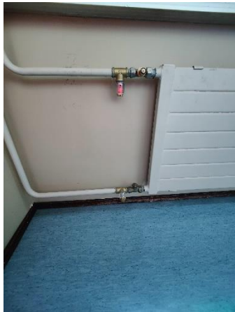
Työterveyden tilasta, jossa on ollut ongelmia lämpötiloissa, on poistettu termostaatti ja lisätty venttiilit ilmausta varten.
