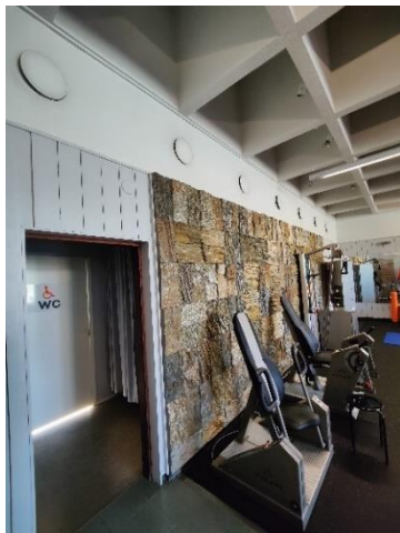
Poistoilmaventtileitä.
