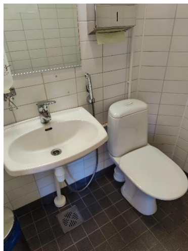
Kirjaston puolella vesikalusteet ovat hyvässä kunnossa.
