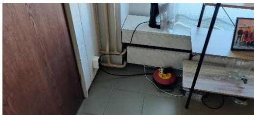
Pistorasioiden sijoittelu ei vastaa käyttötarkoitusta (Fysio)
