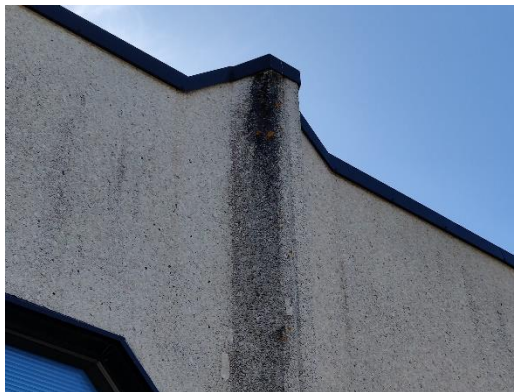
Vesivalumajälkiä julkisivupinnoilla.
