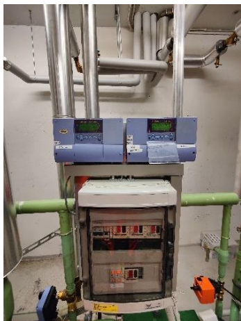
Lämpökeskuksen lämmönsäätimet.
