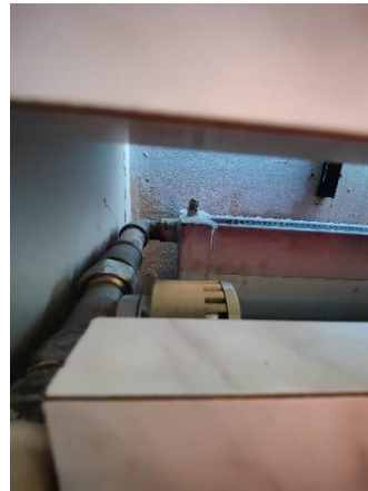
Piilossa olevissa termostaateissa on syytä käyttää irtoantureita termostaatin toiminnan varmistamiseksi.
