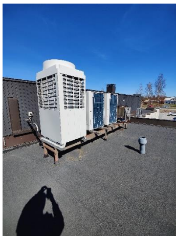
Jäähdytyslaitteiston lauhduttimet.
