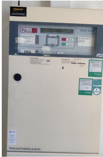
Paloilmaisinjärjestelmä.
