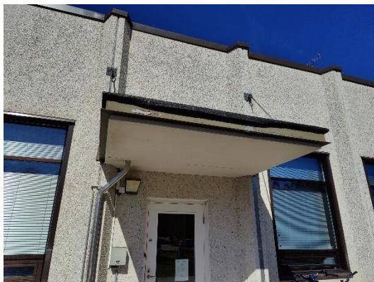
Katoksen rakenteissa ei silmämääräisesti puutteita.
