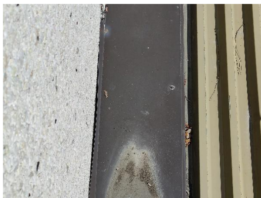
Ylösnostopeltien rajaukset epätiivit.
