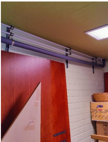
Seinälle kannakoituja viemäriputkia.
