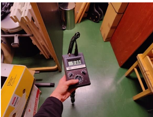
Varaston lattiapinnalla koholla olevaa kosteutta.
