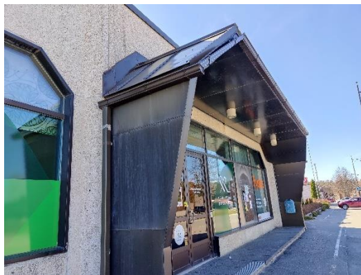
Pääsisäänkäynnin katoksen rakenteissa ei silmämääräisesti puutteita.
