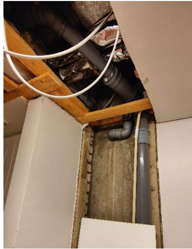
Viemärimuutoksia on tehty muoviviemäriillä.
