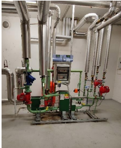
Lämmönjakokeskus.
