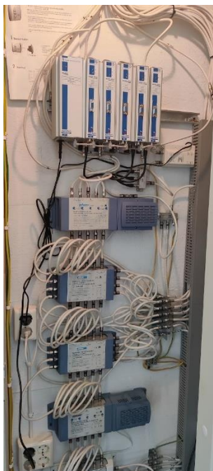
Uusittu TV-antennijärjestelmä (kirjasto).
