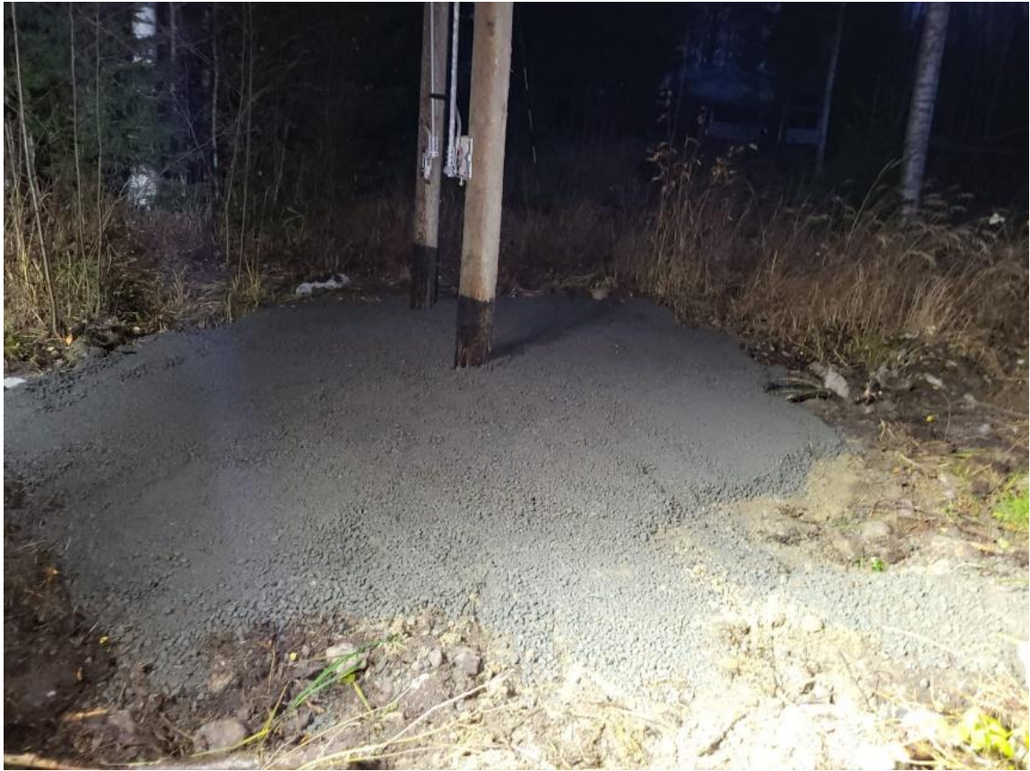
Kuva 2. Kuva kunnostetusta kohteesta.
